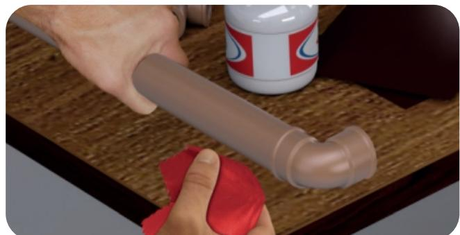
Remova o excesso de adesivo das extremidades. Tempo de cura: 1 hora após a soldagem para liberar o fluxo de água. 12 horas de cura para realizar o teste de pressão sem risco de falhas.
