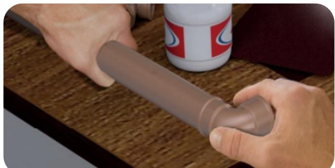
Encaixe o tubo na conexão, certificando-se de que o tubo chegue até o fundo da bolsa da conexão. Atente-se para o correto alinhamento das peças.
