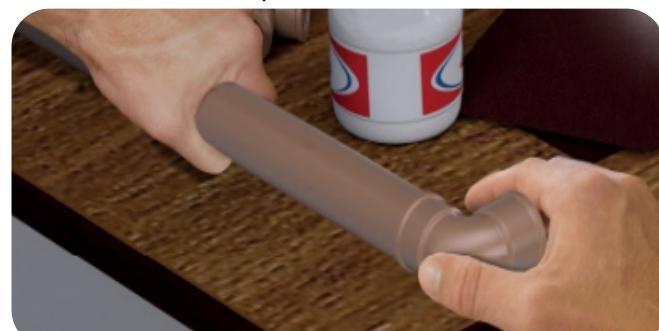
Remova o excesso de adesivo das extremidades. Tempo de cura: 1 hora após a soldagem para liberar o fluxo de água. 12 horas de cura para realizar o teste de pressão sem risco de falhas.
